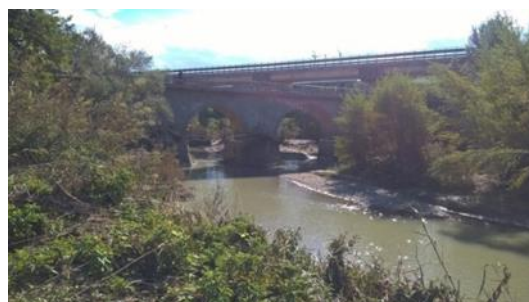
Figura 5 - Ponte Pietra dell'Oglio
